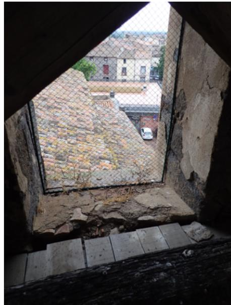
Un travail de rejointoiement, d'amélioration des glacis d'écoulement, de restitution d'abat-sons, seront autant d'éléments qui limiteront l'usure es maçonneries et des bois de charpente du beffroi.
